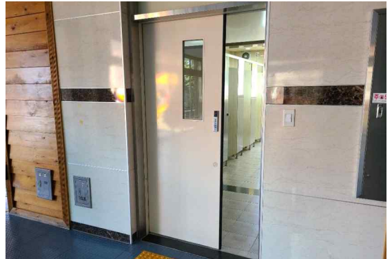
〈사례6 - 화장실 자동문 설치〉
