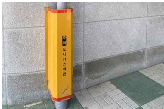
〈사례1 - (양호) 가스배관의 방호구조물 상태〉
