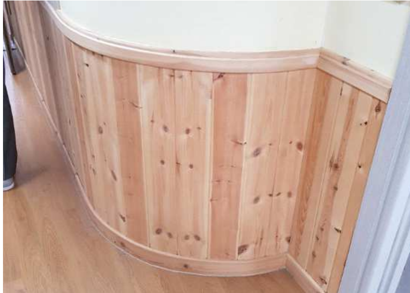
〈사례3 - (미흡) 바닥 단차이 발생〉
