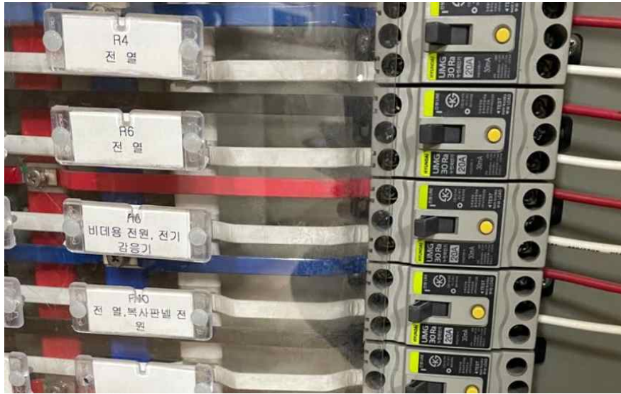
〈사례3 - 누전차단기 설치〉
