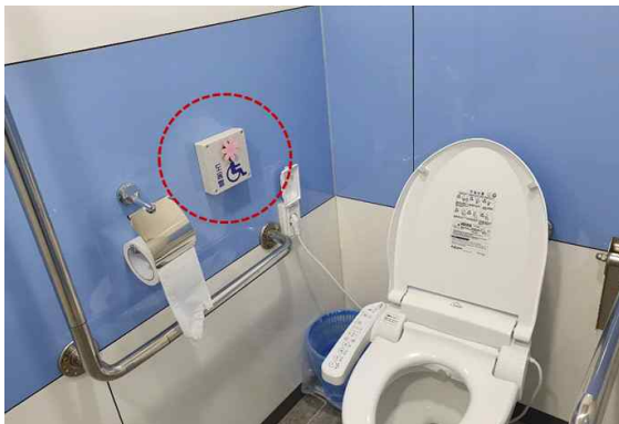
〈사례1 - 화장실 비상벨 설치〉
