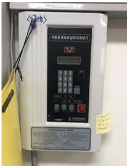
〈사례4 - 자동화재속보설비 설치〉
