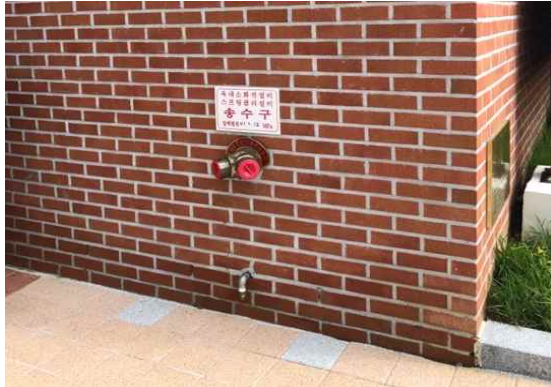
〈사례1 - (양호) 연결송수구 주변 관리상태〉
