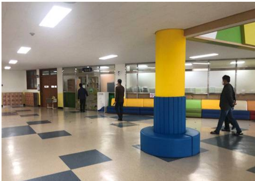
〈사례1 - 홀 기둥에 완충재 설치〉
