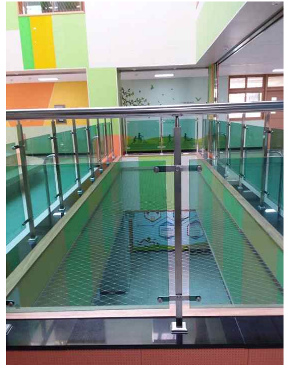
〈사례7 - 2개층 이상 개방된 복도에 낙하물 방지망 설치〉
