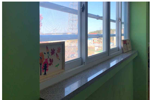
〈사례2 - 안전난간 설치〉
